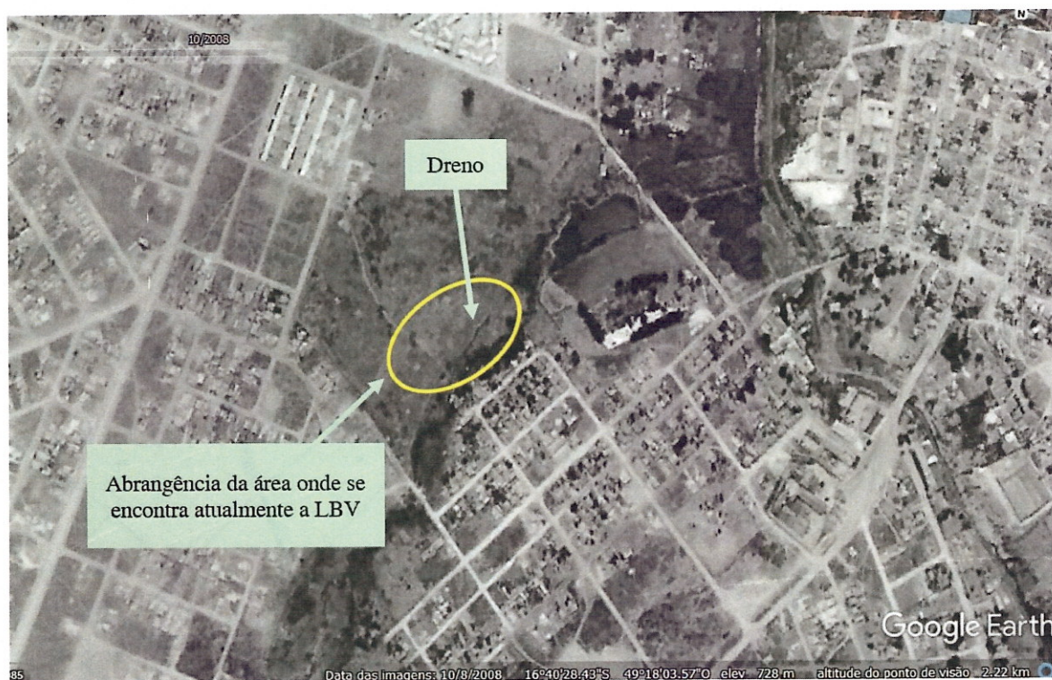
Figura 2: Existência de um dreno artificial na área onde se insere atualmente a LBV. Não foi identificada a existência de nascente.
