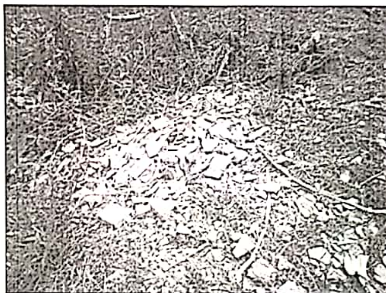
Figura 11: RCC lançado na erosão no interior da chácara.
