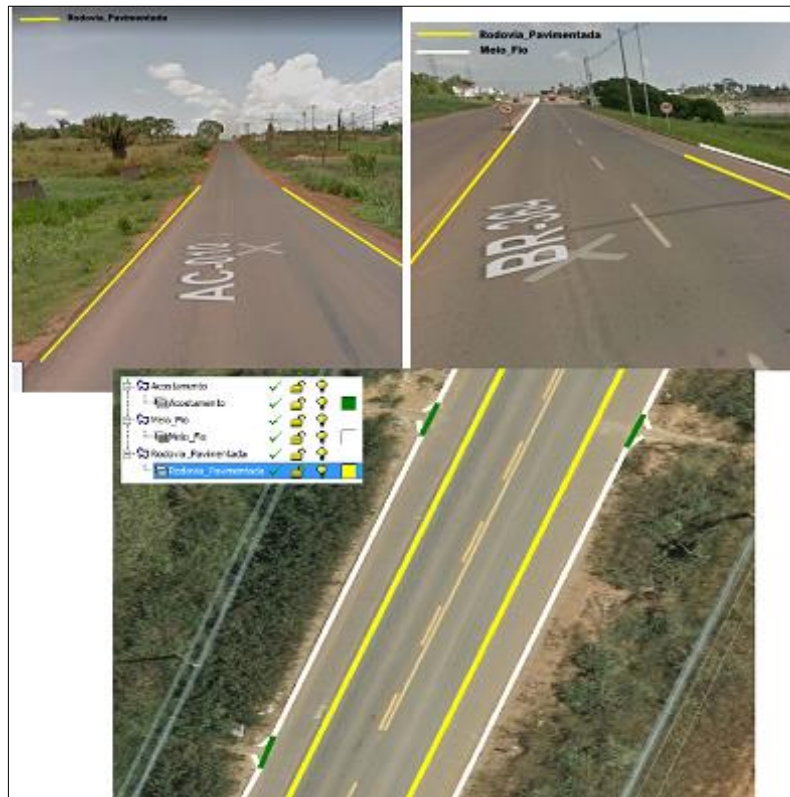
Figura 5 - Exemplos de restituição dos temas Trecho Rodoviário, Meio Fio e Acostamento.
